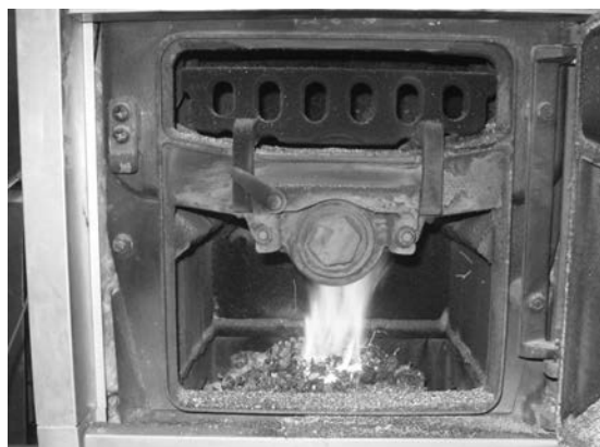
Рис. № 28 Несоответствующая форма пламени
